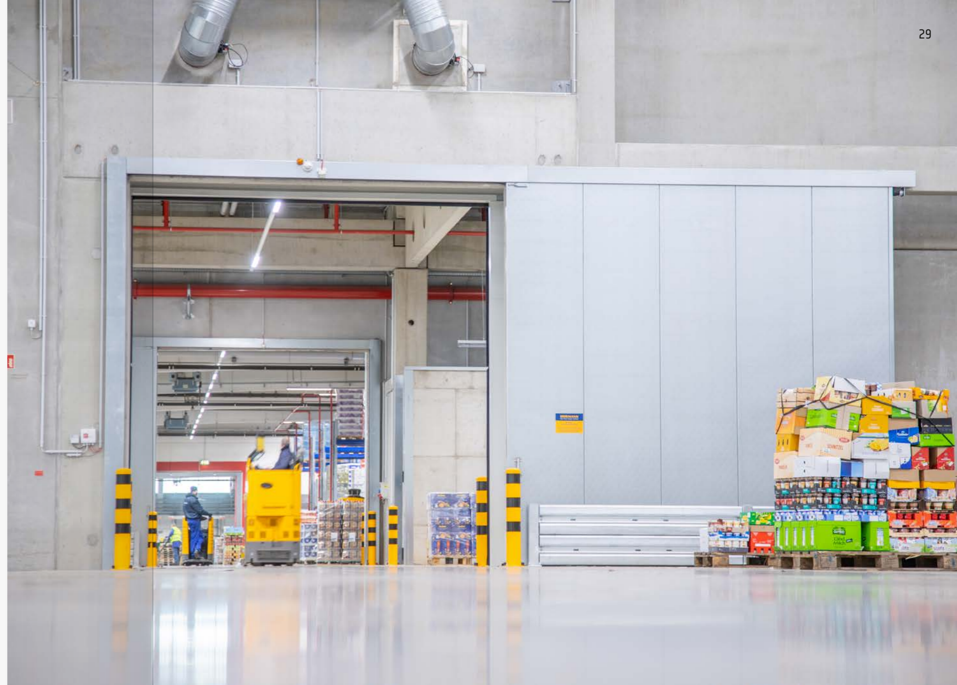
Brandwand-Schiebetor und Brandwand-Durchführung in einer GOLDBECK Kühlhalle
